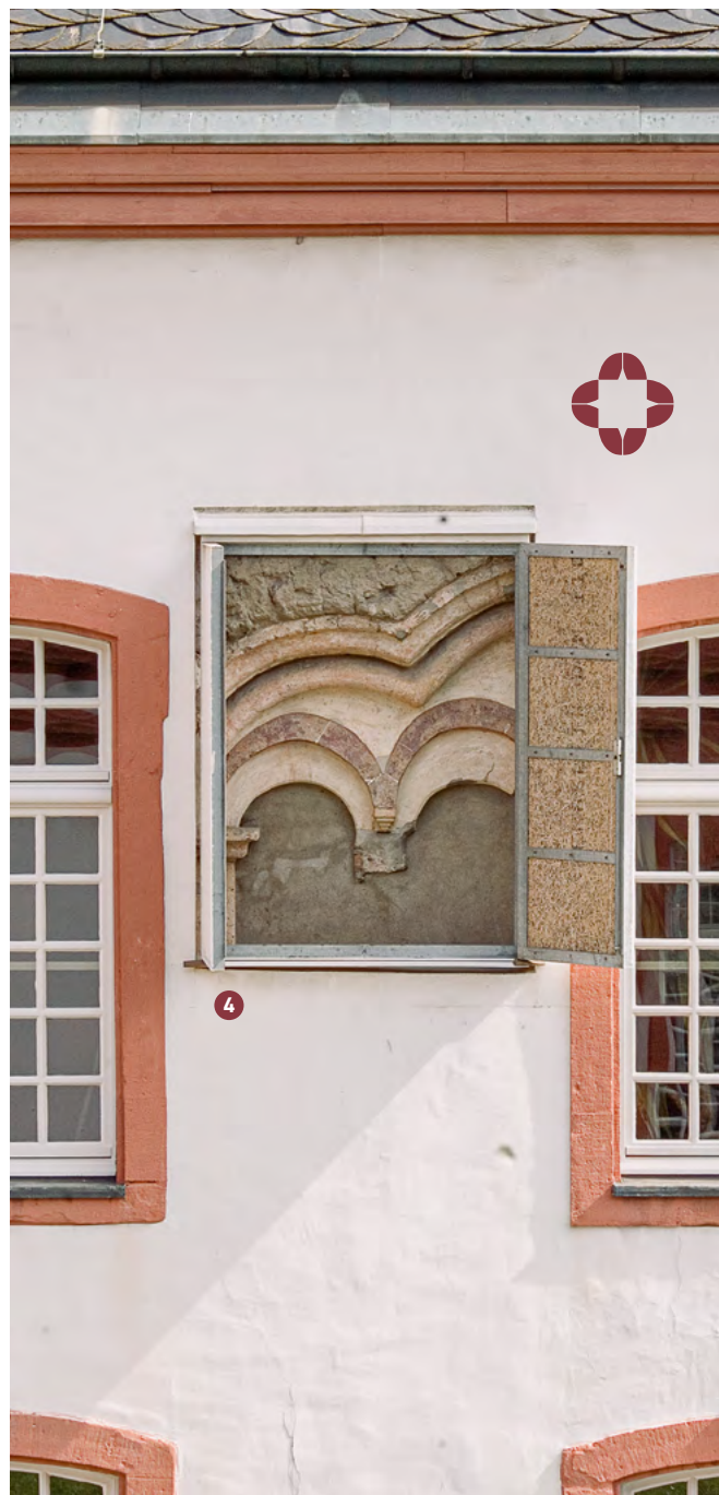
Der Ostflügel der Prälatur ist ursprünglich die Vorderseite des mittelalterlichen Klosterbaus. Die romanische Bauweise kann man unter der barocken Fassade noch durch ein Fenster erkennen.
